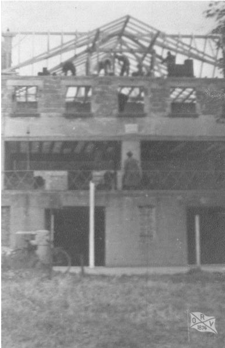
Das ORV Bootshaus im Wiederaufbau
