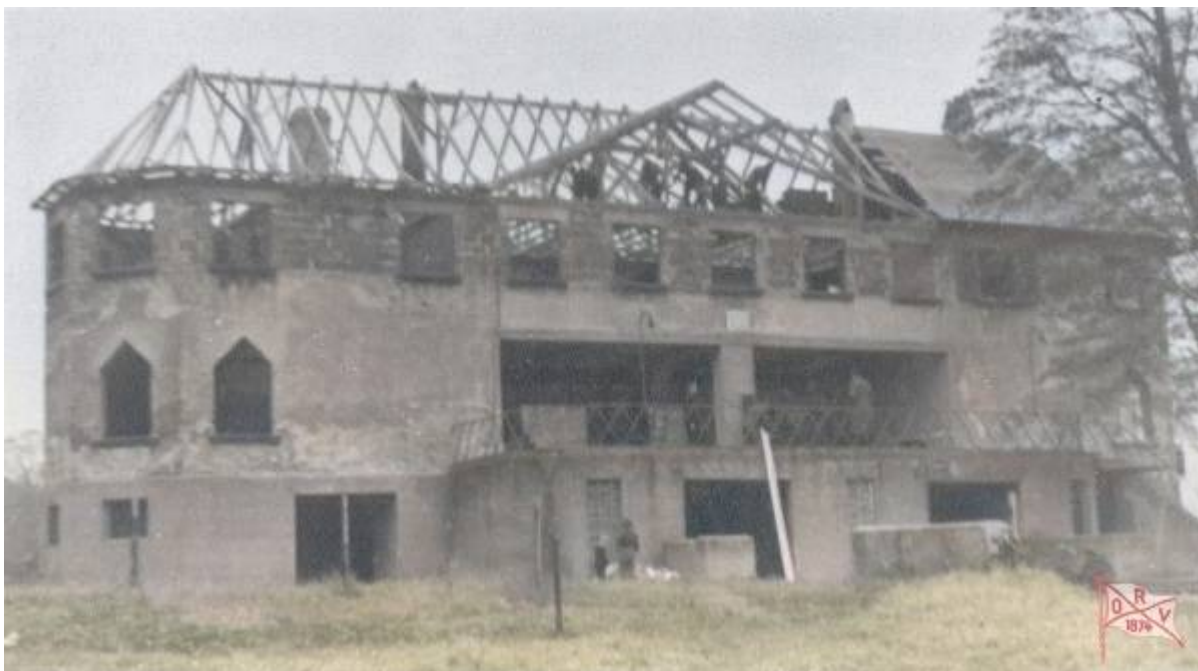
Das ORV Bootshaus im Wiederaufbau
